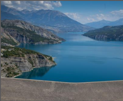
Serre Ponçon – France 380 MW | 650 GWh
